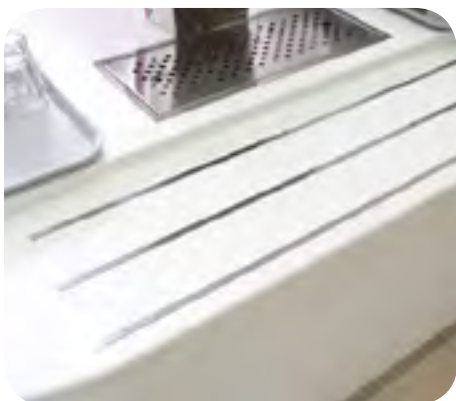
Umelý kameň - STARON, nutnosť zafrézovania alebo nalepenia nerezových líšt po ktorých sa posúva podnos. Aby nedošlo k poškrábaniu materiálu.
